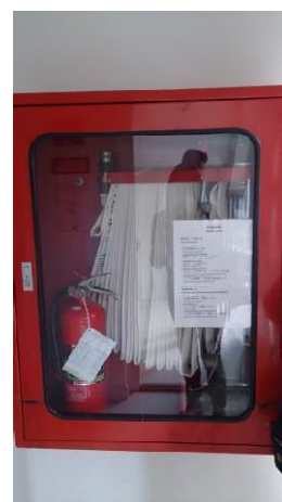
ภาพที่ 1-6 ท่อยืนหัวรับน้ำดับเพลิงและ Fire Host Cabinet
