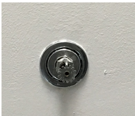
ภาพที่ 1-5 ระบบโปรยน้ำอัตโนมัติ
